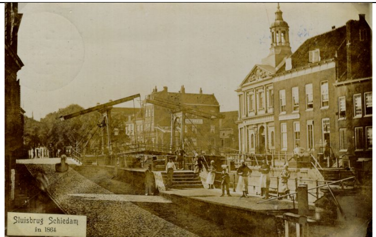
foto (nieuwe) Sluis 1864
