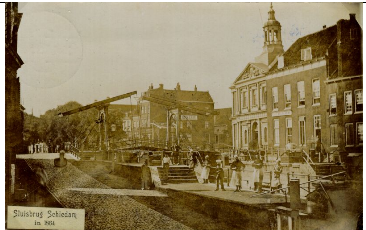
foto (nieuwe) Sluis 1864
